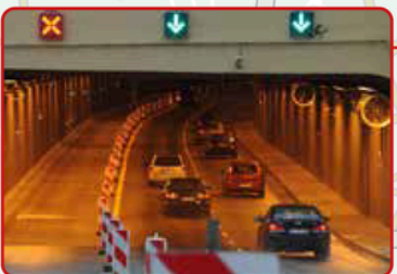
Tunel pod Wisłostradą
