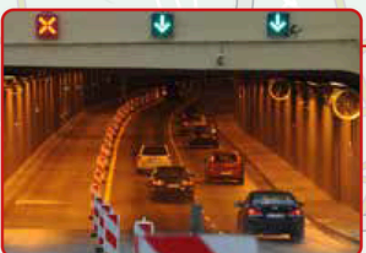
Tunel pod Wisłostradą
