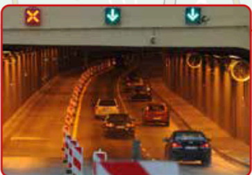
Tunel pod Wisłostradą
