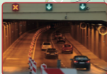
Tunel pod Wisłostradą
